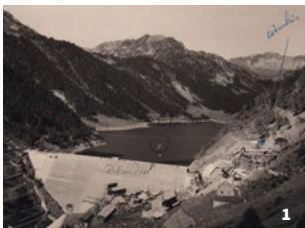
1. Vue générale du chantier de l'Oule - 1949 © Fonds privé Paul Leparoux 2. Ligne du train de chantier entre la carrière et le concasseur © Fonds privé Paul Leparoux
