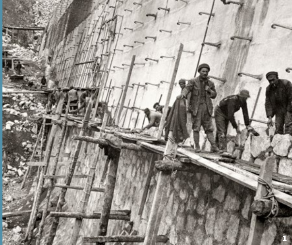
1. Habillage du barrage
