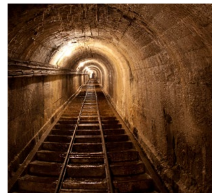
Tunnel d'amenée de l'Oule à Eget © Franck Morinière
